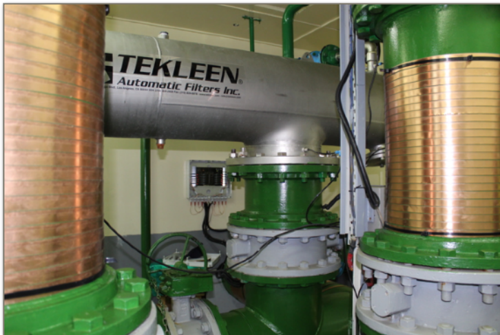
Vulcan S500 a été installé dans la salle des pompes
