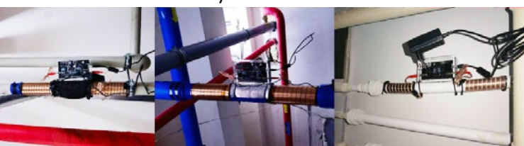
Installations du système anti-calcaire Vulcan.
