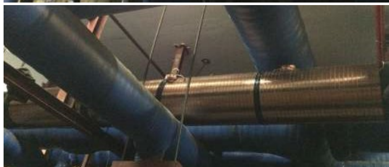
Vulcan S500 installé sur la conduite d'eau de la tour de refroidissement
