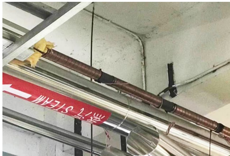
Étape 1 : Installer les bandes à courant d'impulsion
