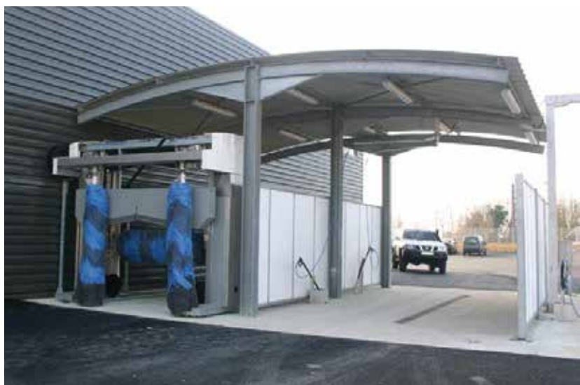
Station de lavage de Clerfond
