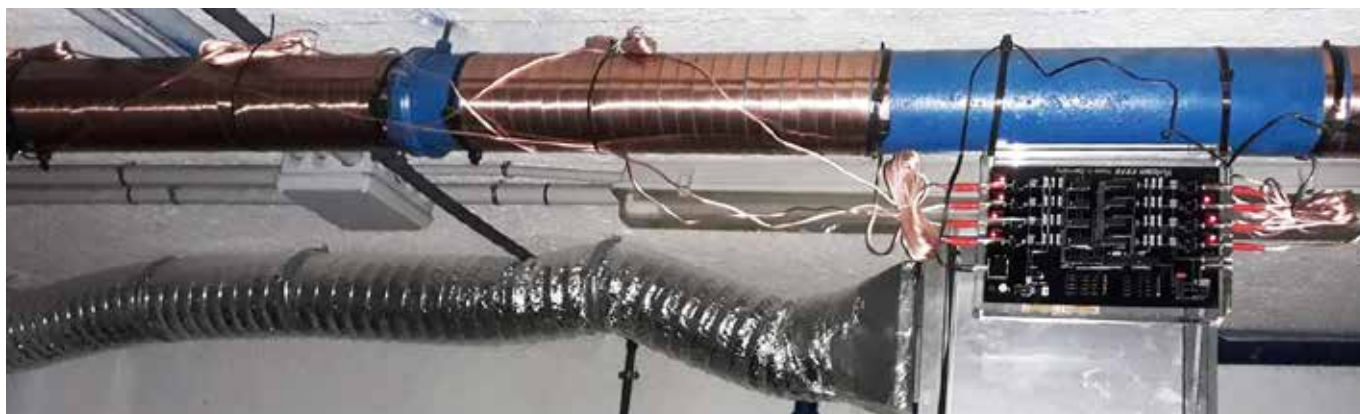
Étape 2 : Installer l'unité S250 sur la conduite d'eau
