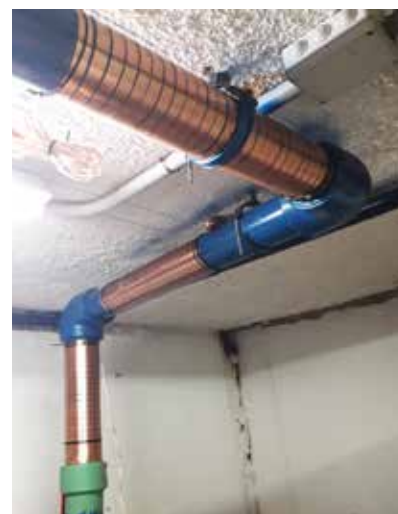
Étape 1 : Installer les bandes à courant d'impulsion
