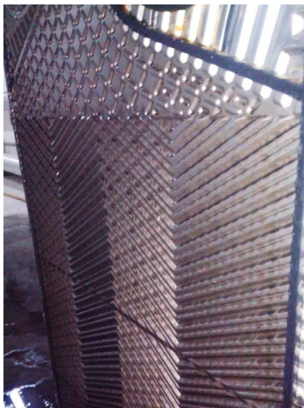
Après avoir installé le S250 pendant 4 mois, les plaques des échangeurs de chaleur ont été ouvertes et sont restées parfaitement propres.
