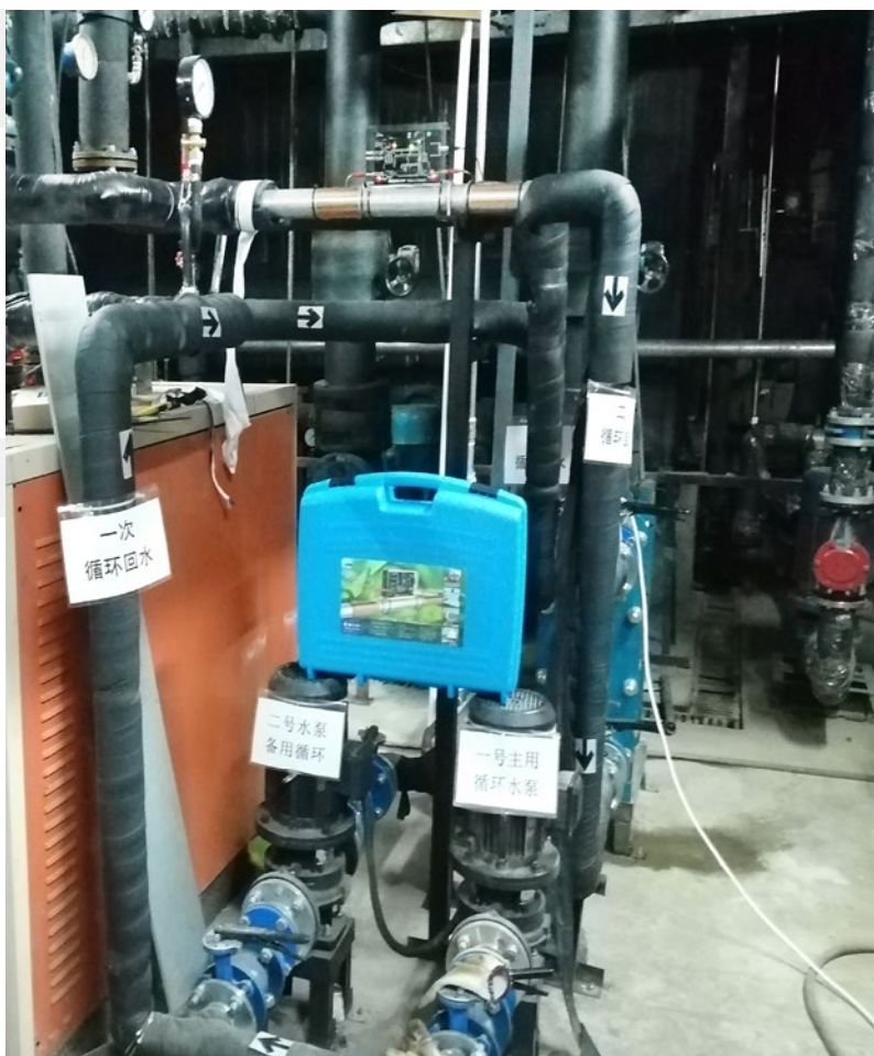
Vulcan S10 a été installé sur le système d'alimentation en eau chaude de l'hôtel.
