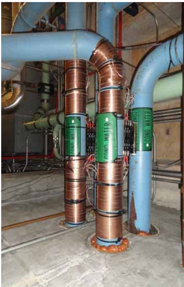
Unités Vulcan S100 installés sur le double refroidisseur
