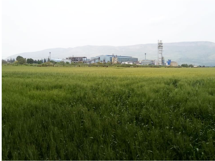
L'usine de Générale Industrie du Nord GINOR.
