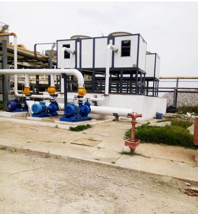
Usine de production de sirop de sucre.
