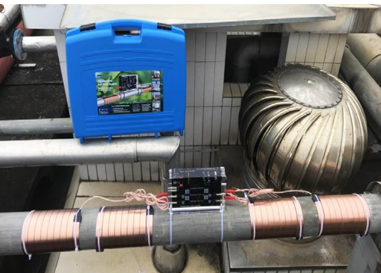
Vulcan S25 a été installé sur la conduite d'eau principale du bâtiment B des chambres d'hôtes.
