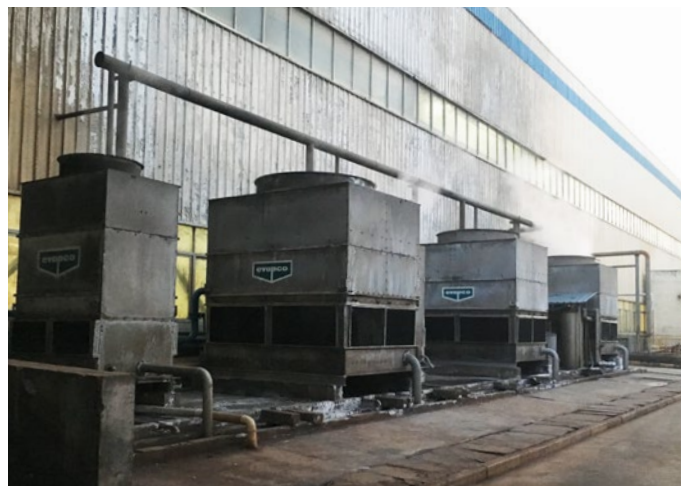
6 tours de refroidissement de l'usine de moulage ont été traitées par Vulcan S25.
