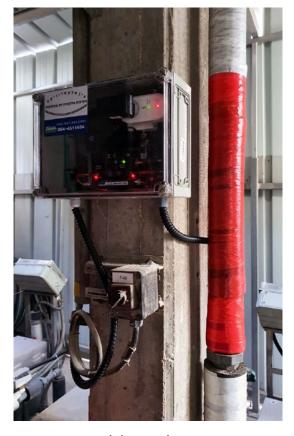
Vulcan 5000 a été installé sur la conduite de retour d'eau du système de chauffage.
