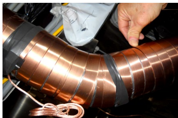
Câbles de Vulcan enroulés deux fois autour d'une conduite d'alimentation en eau
