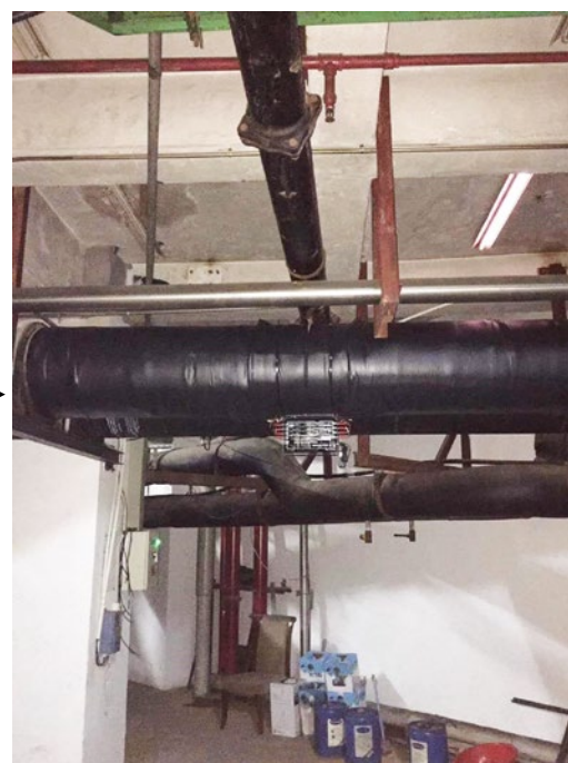
Étape 2 : Le tuyau est enveloppé par un revêtement isolant avant d'installer l'appareil Vulcan S350
