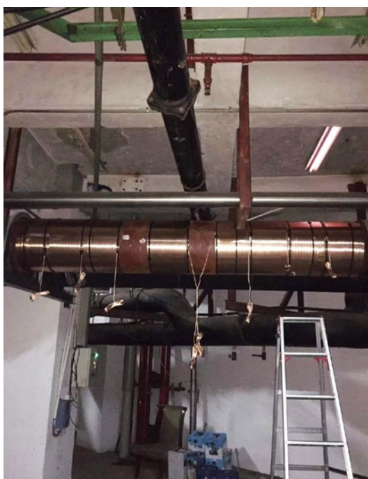
Étape 1 : Installer les bandes à courant d'impulsion
