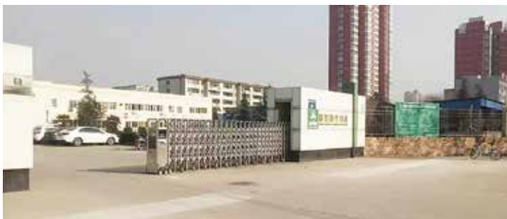
Usine pharmaceutique de Lijun, en Chine.
