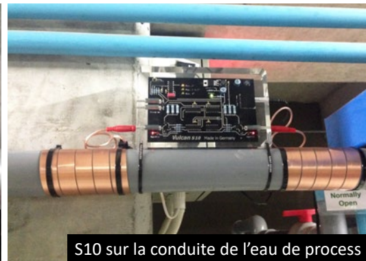
Bandes à courant d'impulsion protégées par le revêtement isolant de la conduite
