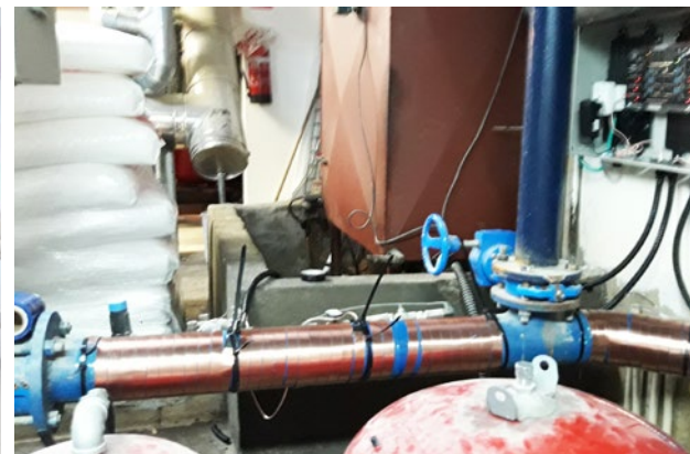
Les sacs de sel visibles sur la gauche ne sont plus utilisés et ont été remplacés par Vulcan.
