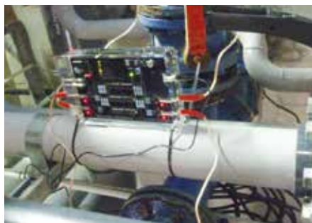
Vulcan S25 installé sur la conduite d'eau principale
