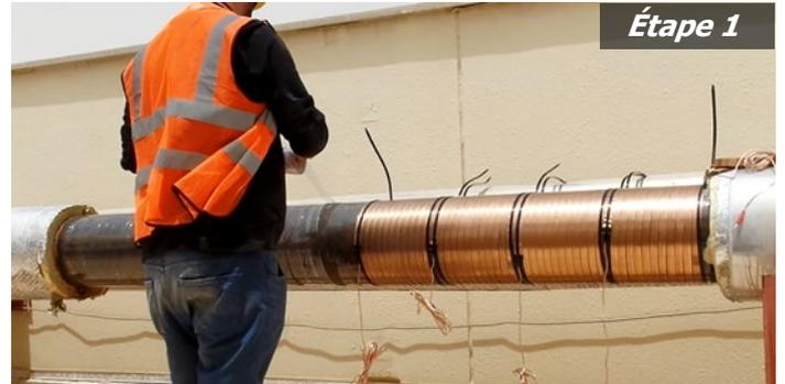
Tout d'abord, enrôler le tuyau de plastique afin de protéger les bandes à impulsion contre la condensation de la conduite.
