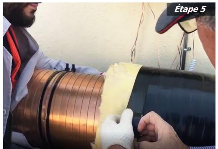
Pour terminer, apposer une couche isolante pour recouvrir complètement les bandes à impulsion et les protéger des éléments.
