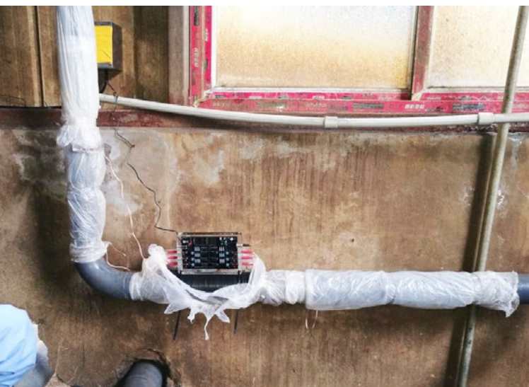
Vulcan S100 a été installé dans la salle des eaux usées afin de traiter la machine de déshydratation des boues.
