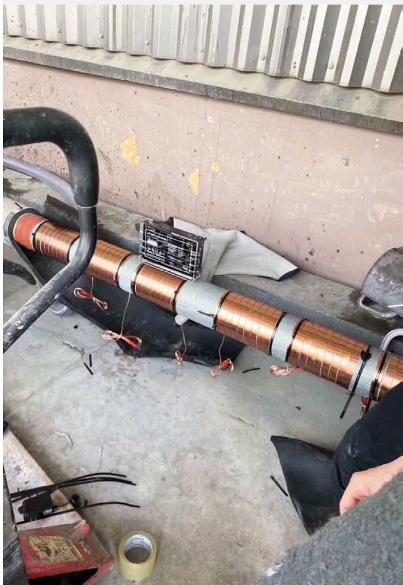
Retrait de l'isolation du tuyau et installation de Vulcan S100.
