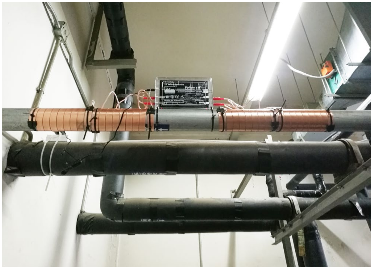
Vulcan S25 a été installé sur la conduite d'eau principale de la tour de refroidissement.
