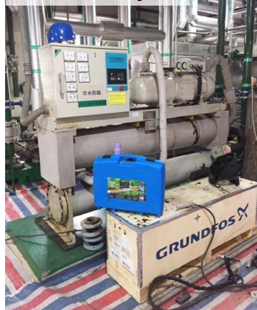
Les unités Vulcan S25 ont été installées sur les conduites d'entrée et de sortie de la tour de refroidissement afin de palier aux problèmes de calcaire touchant la salle d'alimentation n° 3.
