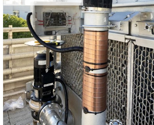
Les unités Vulcan S25 ont été installées sur les conduites d'entrée et de sortie de la tour de refroidissement afin de palier aux problèmes de calcaire touchant la salle d'alimentation n° 3.
